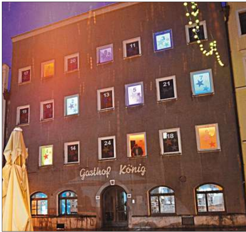
An der Fassade des ehemaligen Gasthofs König an der Hauptstraße wird im Advent wieder jeden Tag ein neues Fenster beleuchtet. – Fotos: cl
